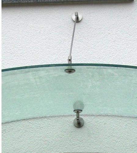
**1.** Setzen die Zugstangen in die oberen Wandhalter ein. Befestigen Sie diese aber vorerst nur mit 2 Umdrehungen.
